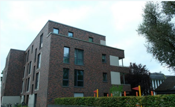
Blick auf den KfW-70-Neubau am Wolkausweg in Hamburg Quelle: KEDi
